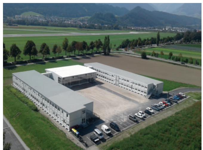
Ausweichquartier der BRG Sillgasse
