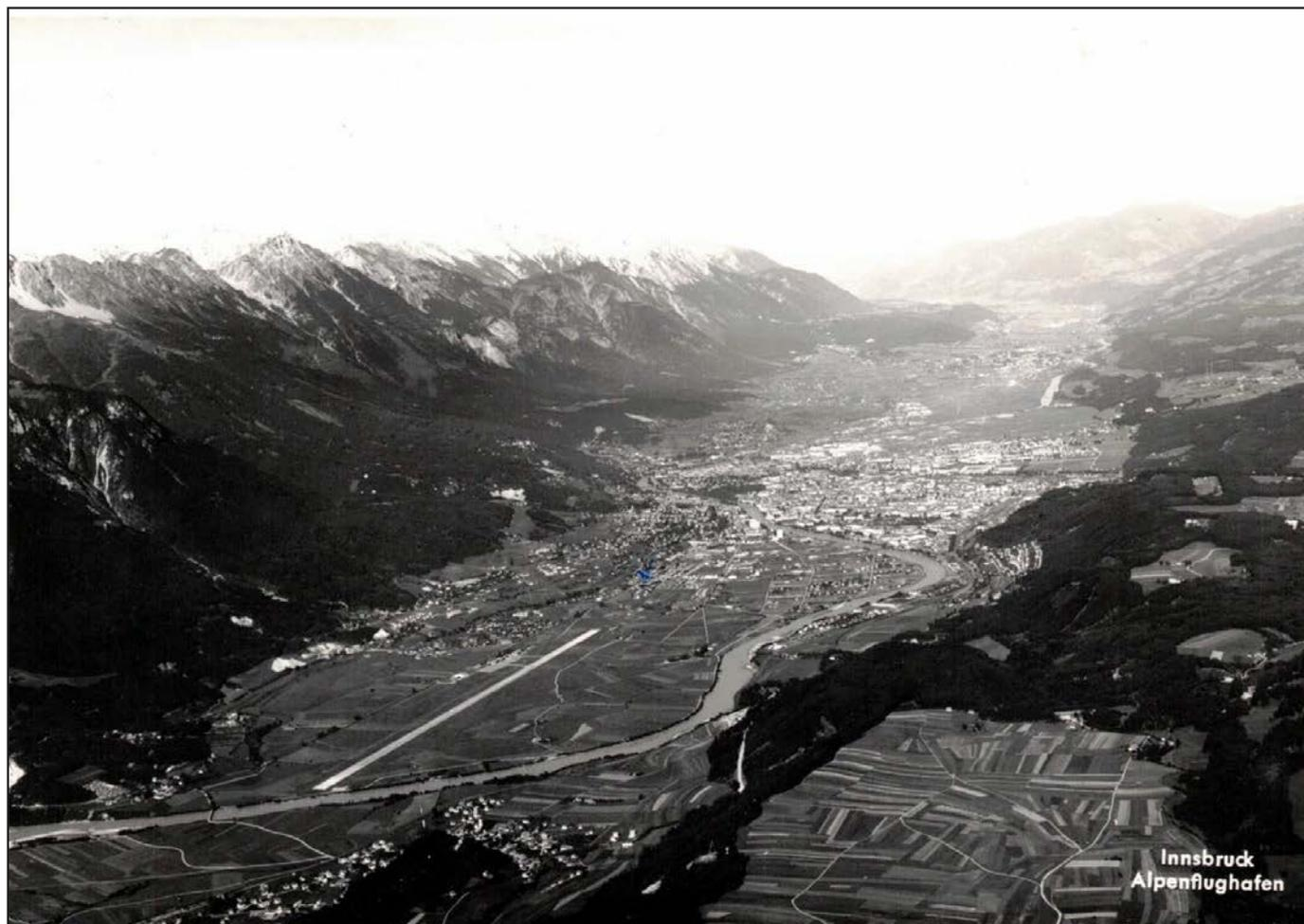
Nach jahrzehntelangem Betrieb wurde zwischenzeitlich eine grundlegende Generalsanierung der Piste am Flughafen Innsbruck erforderlich. Dieses Postkartenfoto, datiert 15.10.1962, zeigt Innsbruck mit dem neu errichteten Flughafen "Innsbruck West". Im weitgehend unbebauten Umland erkennt man die 1140m lange Betonpiste mit den damals noch nördlich gelegenen Flughafengebäuden.
