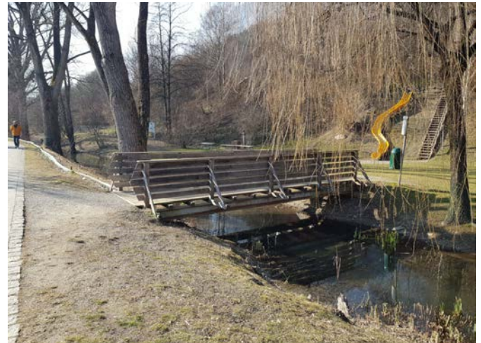
Die alte Brücke im Bestand
