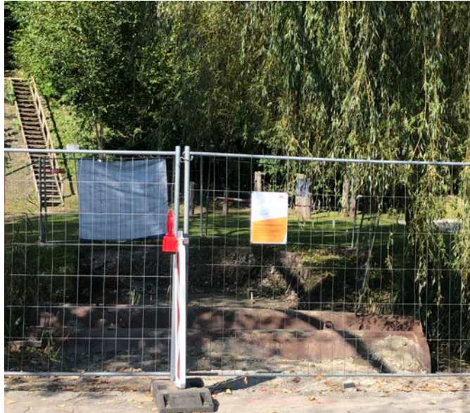
Die Baustelle der Lohbachbrücke 2023
