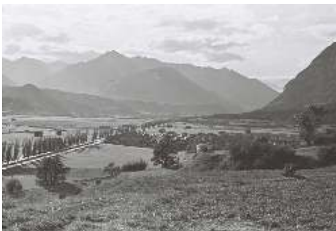
Blick auf die Lohbachsiedlung 1943
