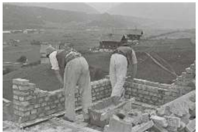
Maurer beim Hausbau 1936, im Hintergrund die Höttinger Au
