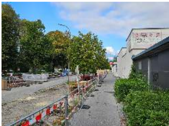
Zu Fuß erreichbar, per Auto gesperrt: Die Nebenfahrbahn an der Kranebitter Allee gleicht einer Großbaustelle.
