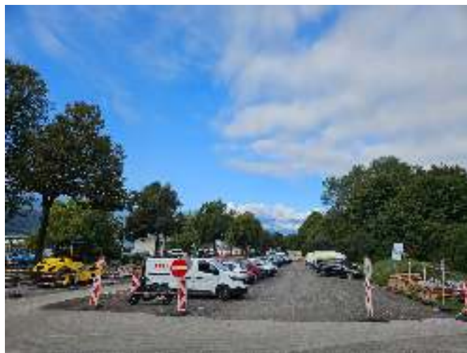
Der Ersatzparkplatz im Westen des Bauareals kann über die Technikerstraße (Westspange) und die Nebenfahrbahn der Kranebitter Allee angefahren werden.
